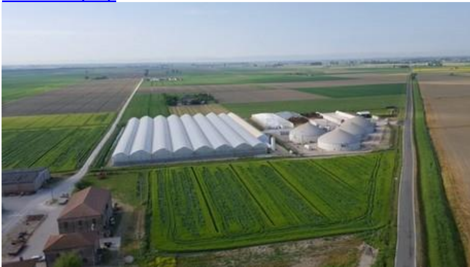
Una veduta aerea di serra e impianto di cogenerazione a Crevalcore (BO).
